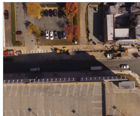
PECO Ductbank Relocation
